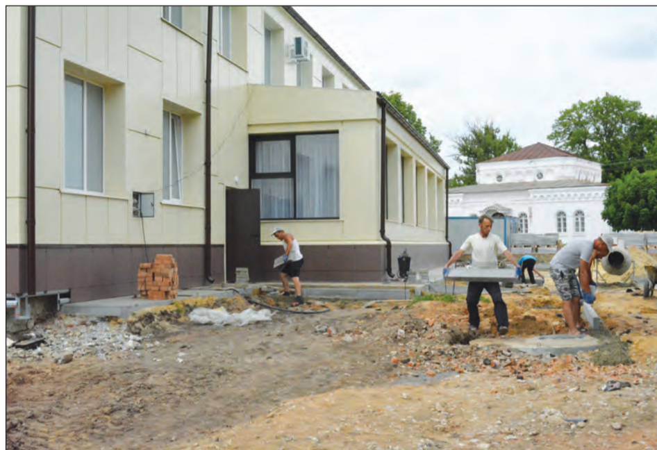
До конца июня будет завершено благоустройство прилегающей к РДК территории
