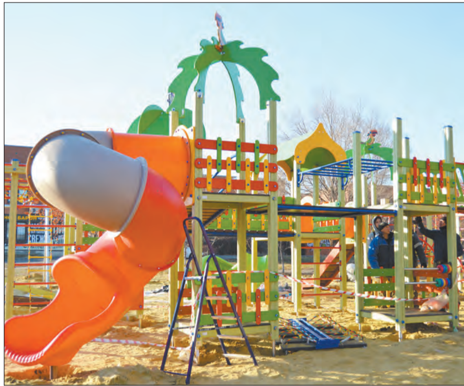
■ Детский игровой комплекс смонтировали за три дня
