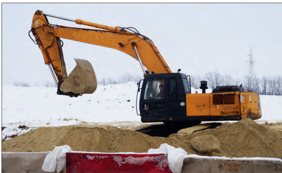
■ Работы на транспортной развязке возле хутора Дядин идут полным ходом
