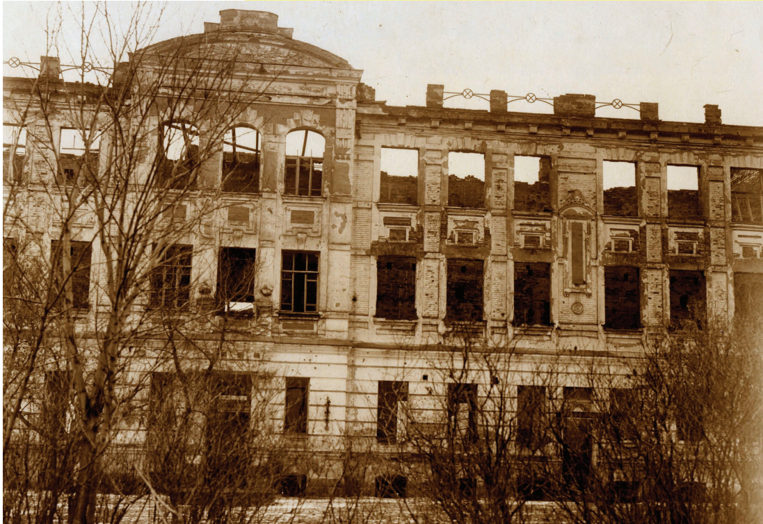
Разрушенное здание школы-интерната им. Шолохова. 1943 год
