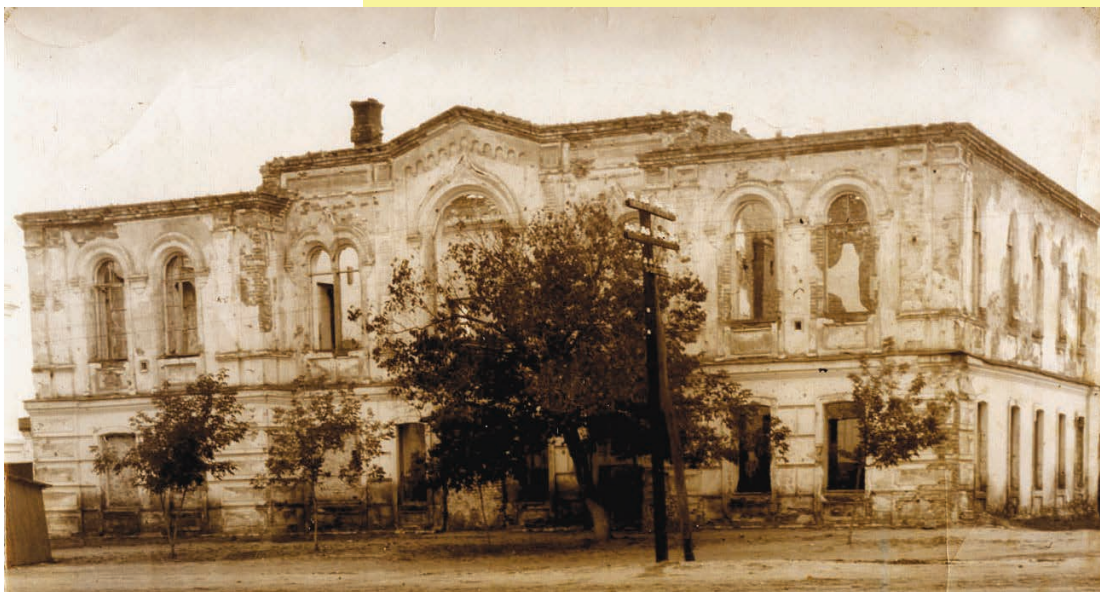
Разрушенное здание школы Александровского училища. 1943 год
