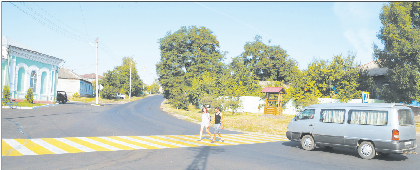
В Богучарском районе идет обновление дорожной инфраструктуры
