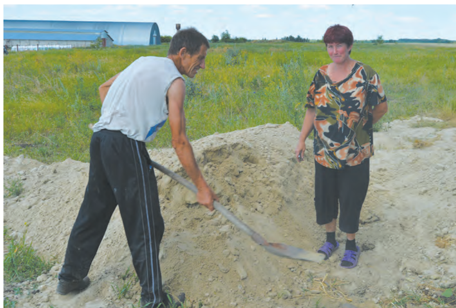
■ Супруги Никишкины расчищают территорию возле строящегося коровника
