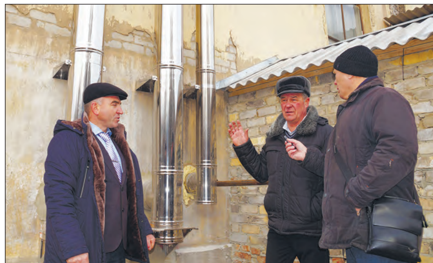
Алексей Ромащенко (слева) рассказывает, как шло строительство котельной
