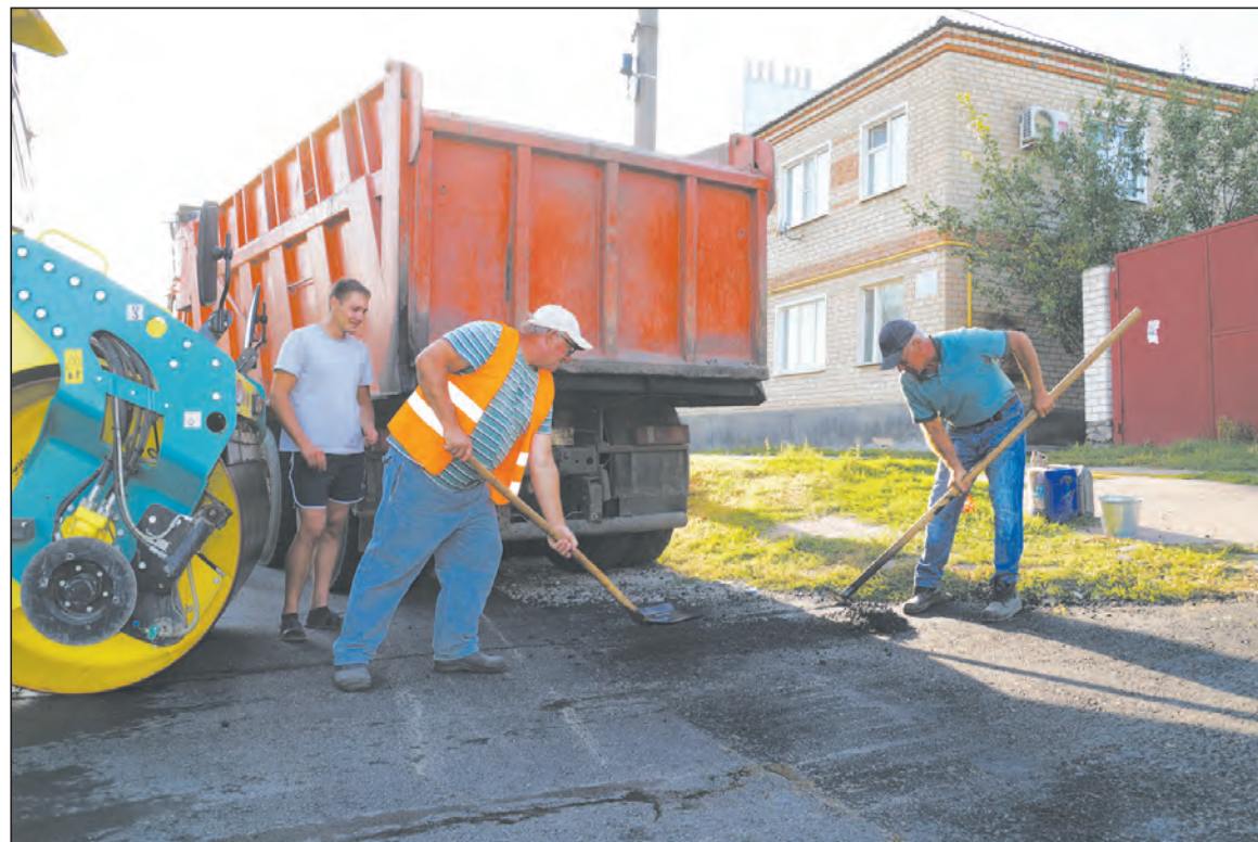
Работы ведутся на улице К. Маркса в Богучаре
