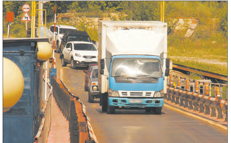
■ Авто грузоподъемностью до 5 тонн по мосту проезжают
