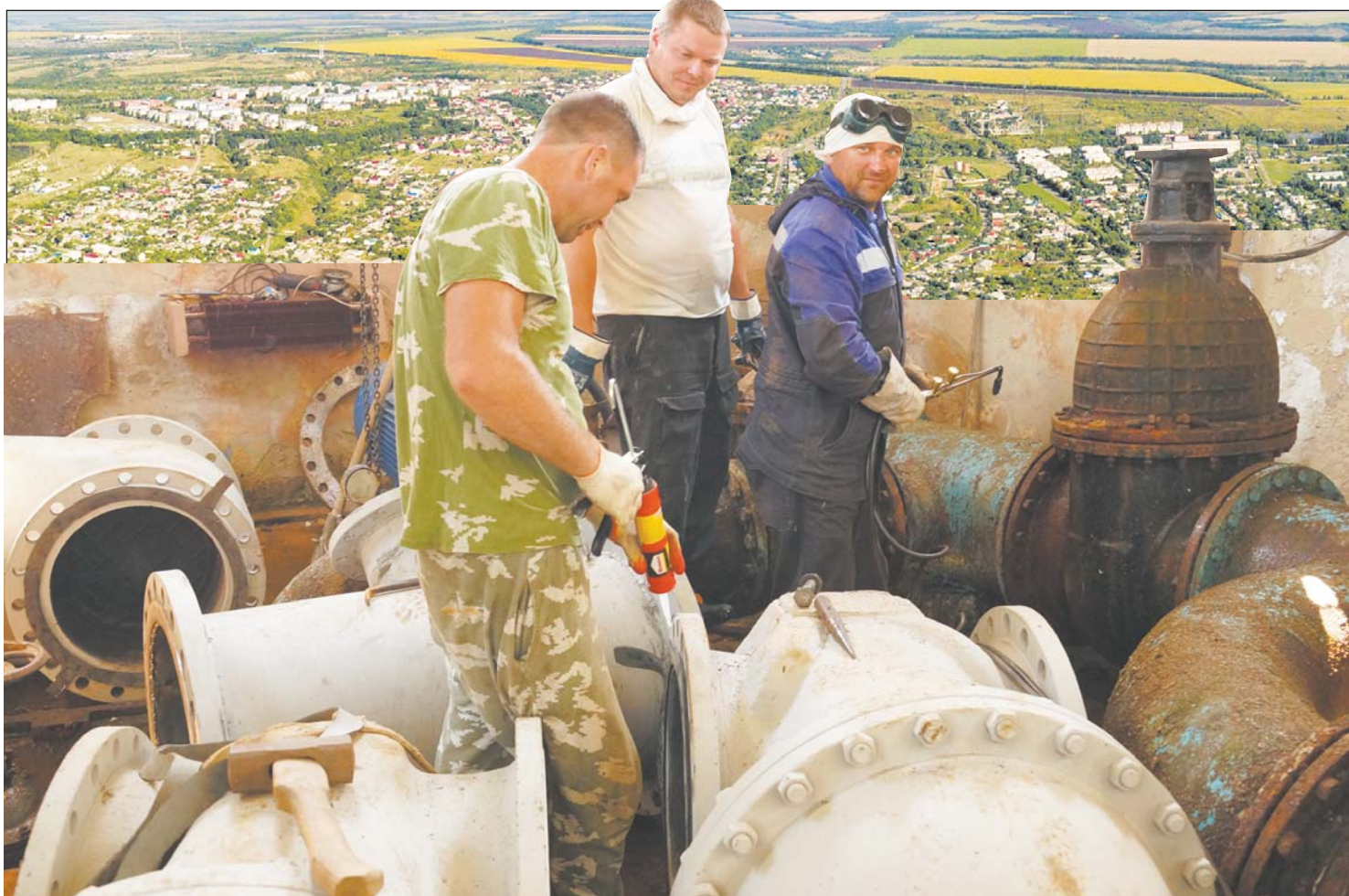
■ Благодаря ремонту в городе будут реже отключать воду из-за аварий на станциях
