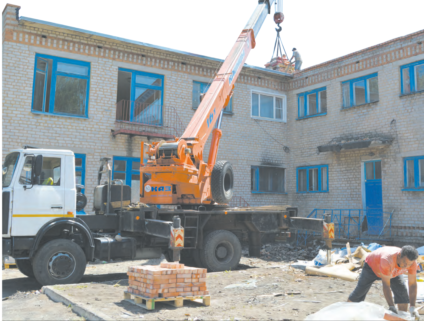
Ремонт в «Родничке» начали с замены кровли
