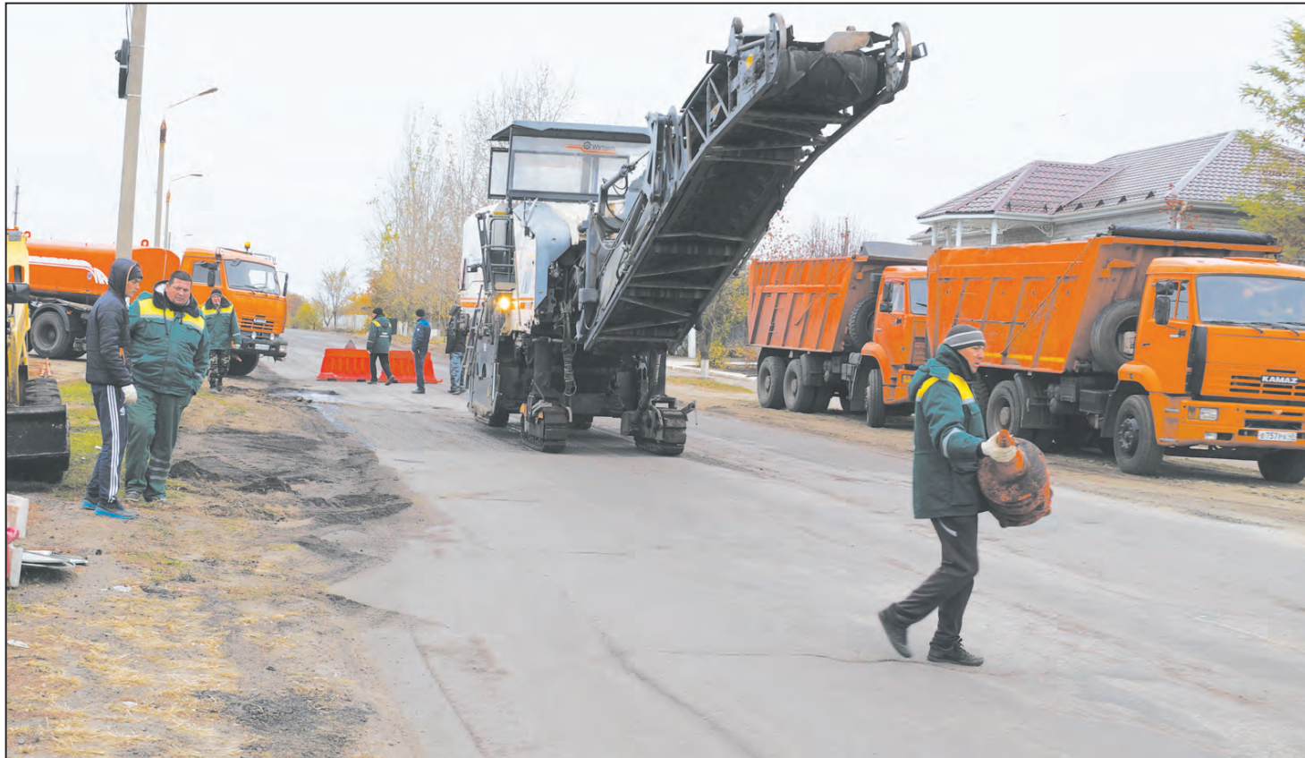
На фото – одна из стадий ремонта дороги
