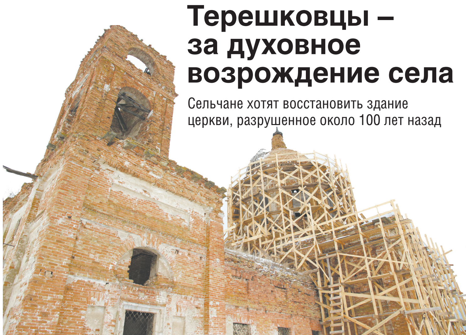
Работы по восстановлению церкви Вознесения Господня уже начались
