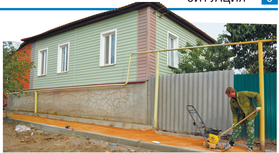
На фото — работа по укладке тротуара на улице 1-е Мая
