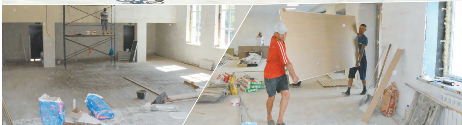
Уже выполнена основная часть работ
