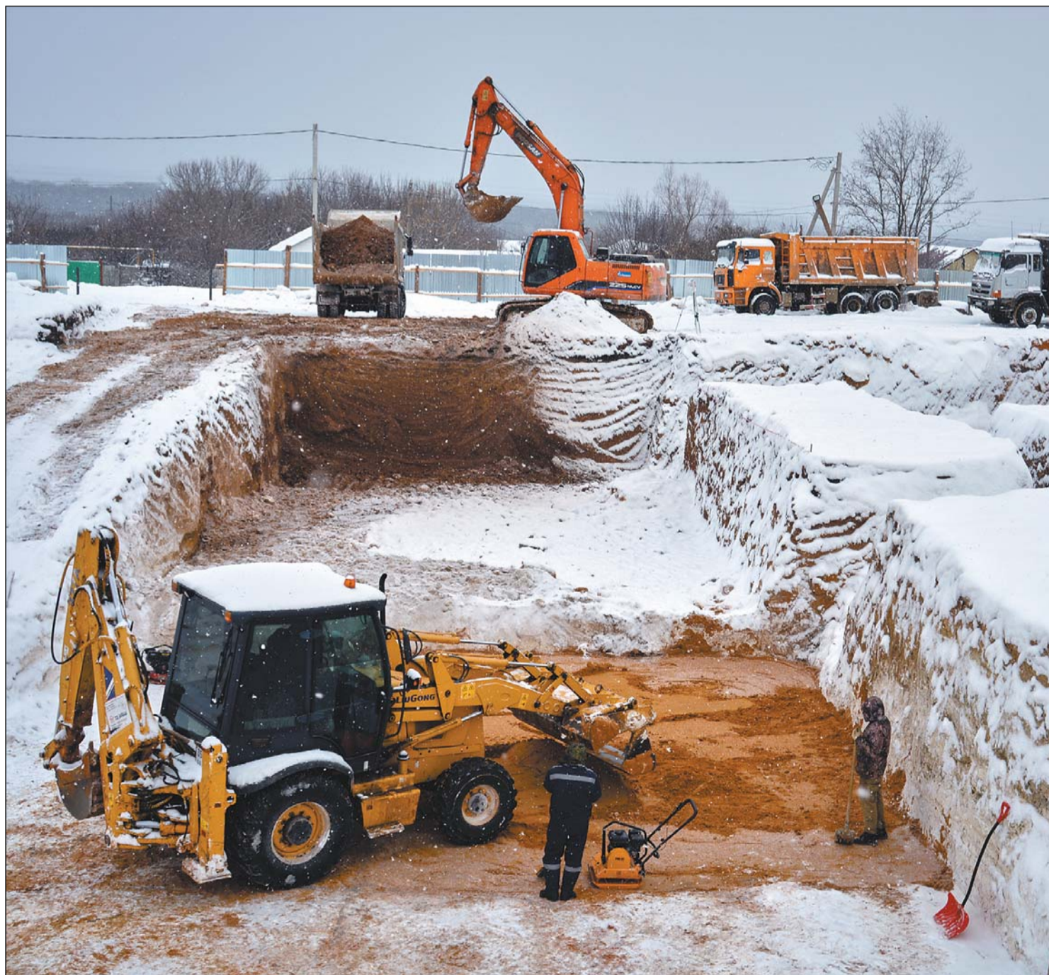
Работа на стройплощадке идет полным ходом
