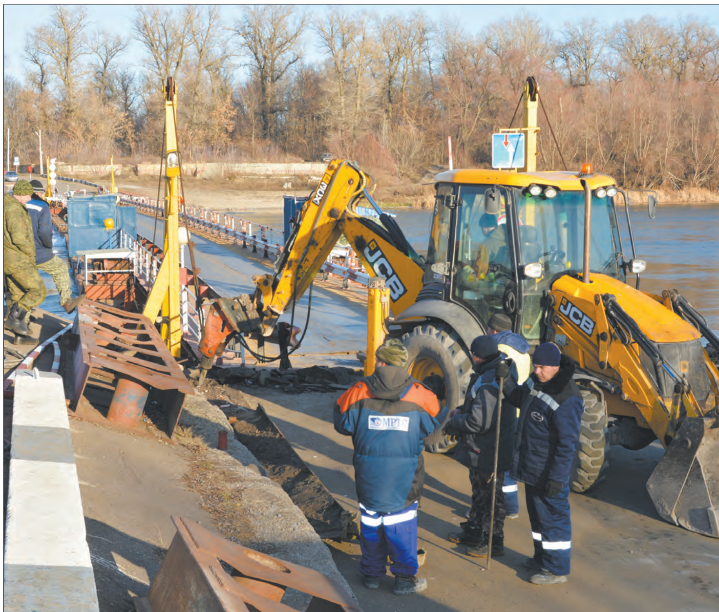
Ремонтные работы на переправе начались вовремя
