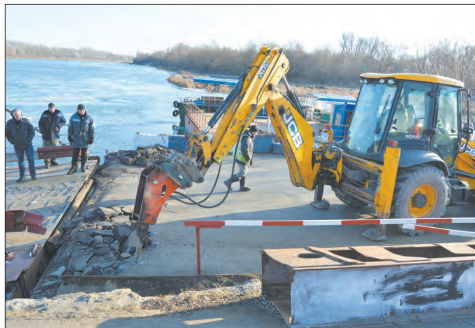
Старое асфальтовое покрытие снимают с помощью пневматического молота
