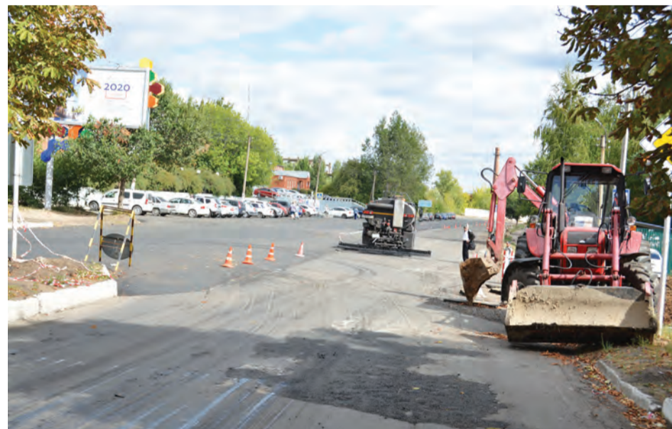
Работы на проспекте 50-летия Победы будут завершены в ближайшее время
